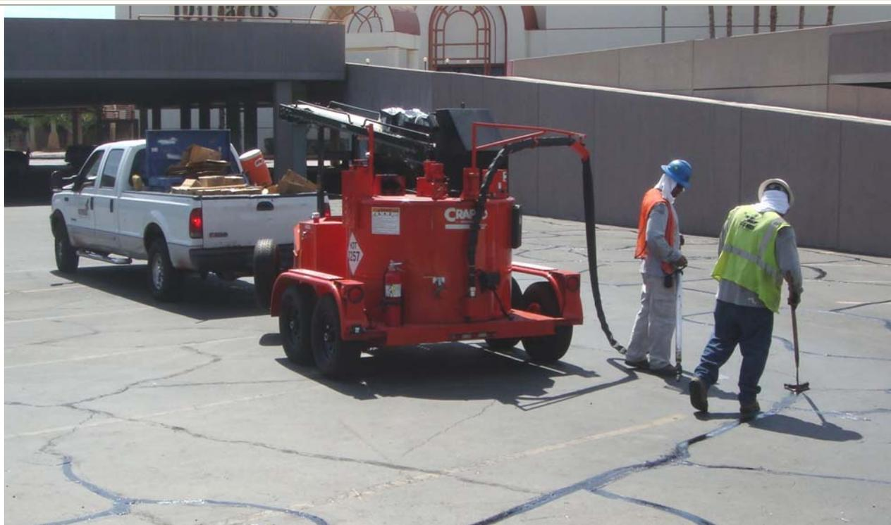
Le **SIGILLATRICI SSC** sono costruite in collaborazione con **Crafco**°, azienda leader del settore, ed offrono una gamma completa di macchine adatte a risolvere in modo semplice, economico e duraturo nel tempo, tutte le problematiche inerenti il trattamento delle crepe del manto stradale, preservandolo dall'infiltrazione degli agenti esterni, quali acqua e ghiaccio, ed evitando così la rottura degli strati inferiori di asfalto e la conseguente formazione di pericolose buche e rotture.
